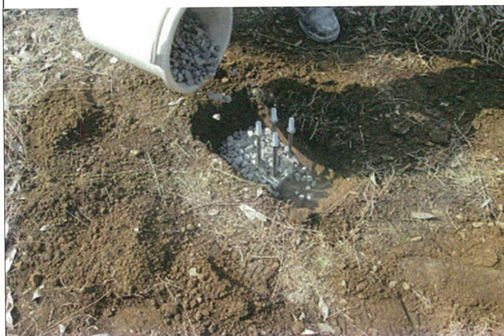
適用例(農業ハウス支柱基礎工事):粗骨材投入状況
