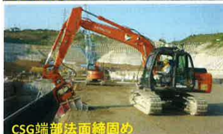
図-3 CSGの施工方法
