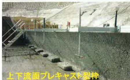
図-3 CSGの施工方法
