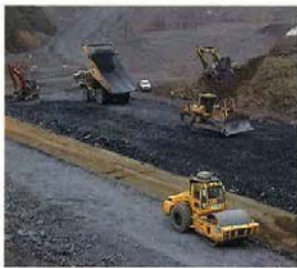
従来の重機による作業(ダム現場)
