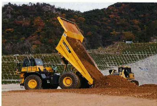
自動ダンプトラックと自動ブルドーザの連動作業
