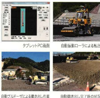
自動ブルドーザによる撒き出し作業 自動振動ローラによる転圧
