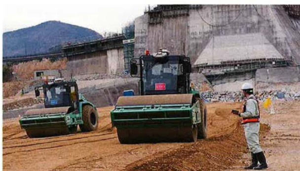
コア盛立部での2台の自動振動ローラでの転圧作業
