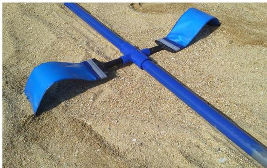
写真-1 ドレーンと集水管接続例
