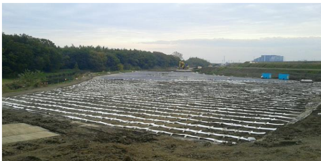
写真-2.1 施工状況
