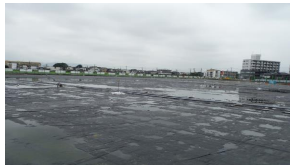
写真-2.2 真空運転状況
