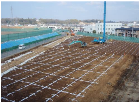
写真-2.1 水平ドレーン布設状況
