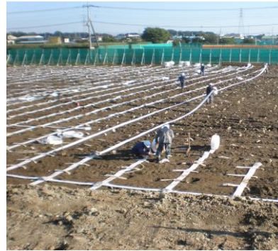
写真-2.2 水平ドレーン布設状況
