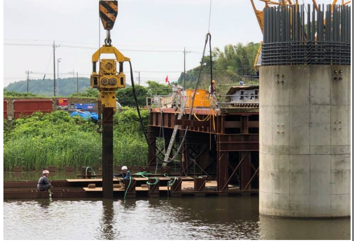
ため池内でのH鋼引抜き
