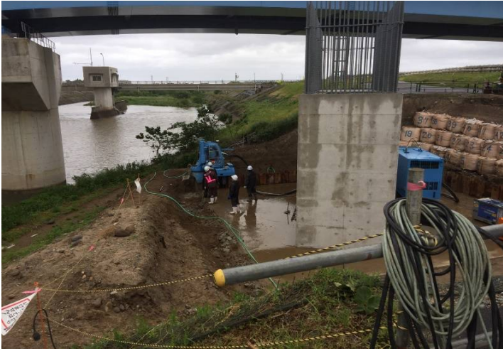
河川堤防内での引抜き跡処理
