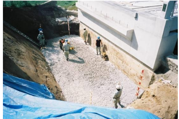
写真-2 既設橋台背面での施工事例
