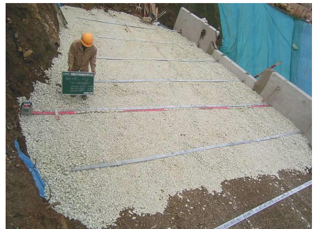
写真-1 補強土壁との併用事例
