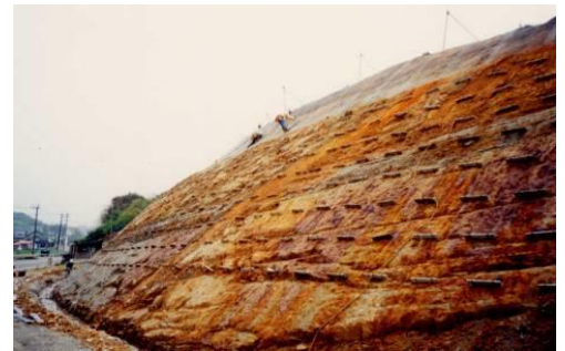
写真-4 ミラクルボードの設置状況
