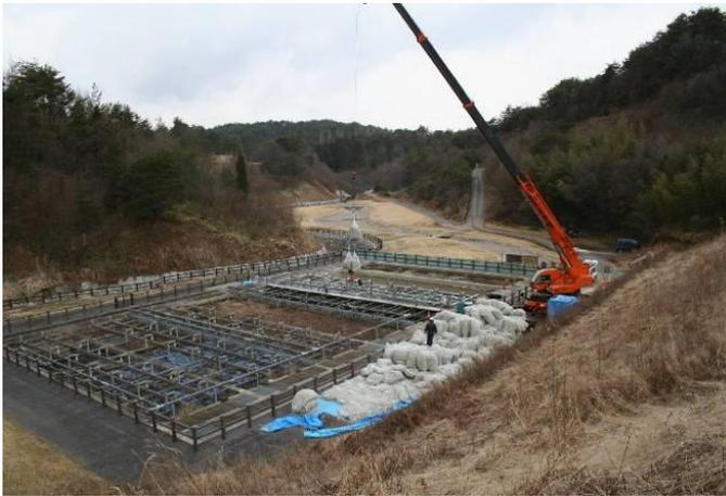
写真-3 ダムの流入河川浄化施設事例
