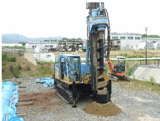
掘削状況(完全乾式)
