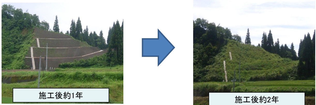
図-3 施工経過写真
