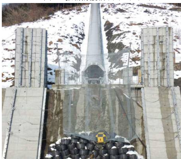
図-4 実験状況(誘導後)
