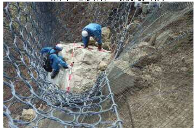
土砂捕捉実績
