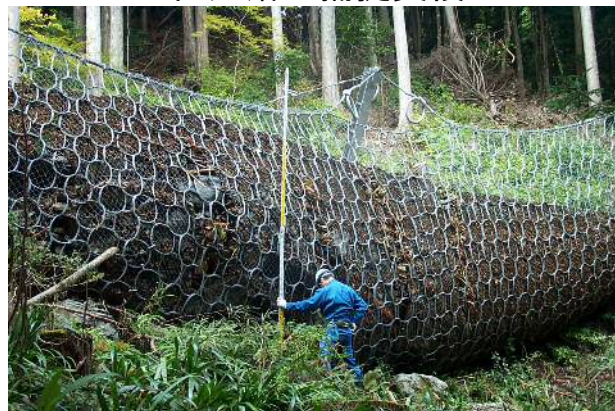
土砂捕捉実績
