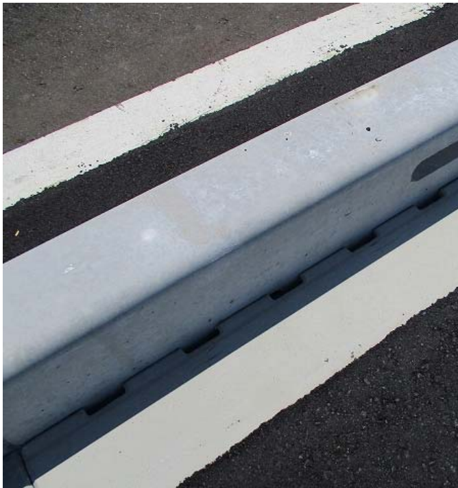
写真-1 施工現場写真
