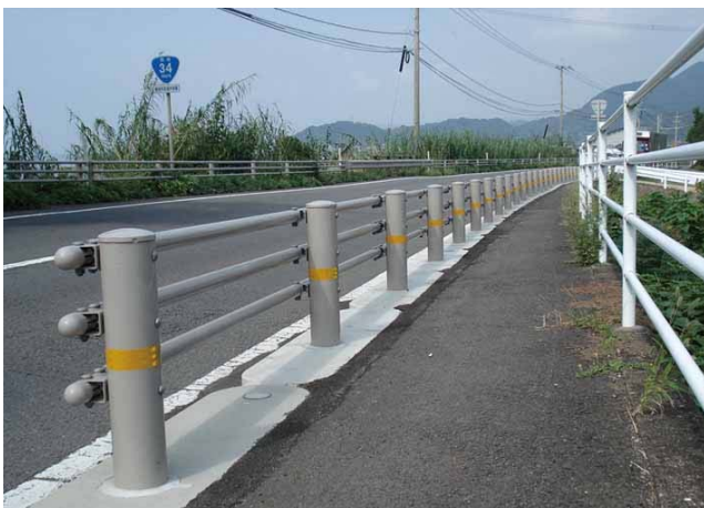
写真1 施工現場—本設
