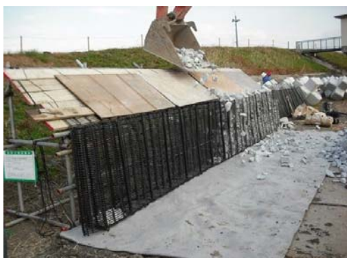
中詰材充填用架台、中詰材充填
