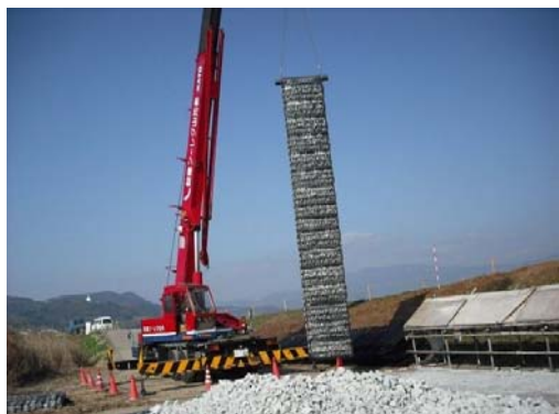
吊上げ状況 《片吊り》
