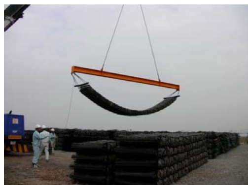
吊上げ状況 《両吊り》
