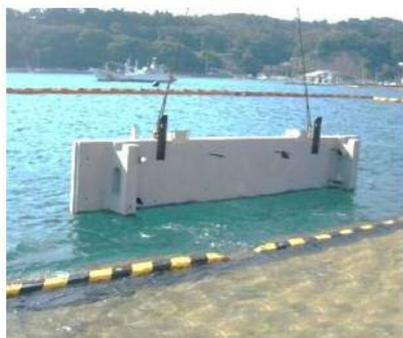
写真 1-5 残置型枠の吊り込み状況(例)
