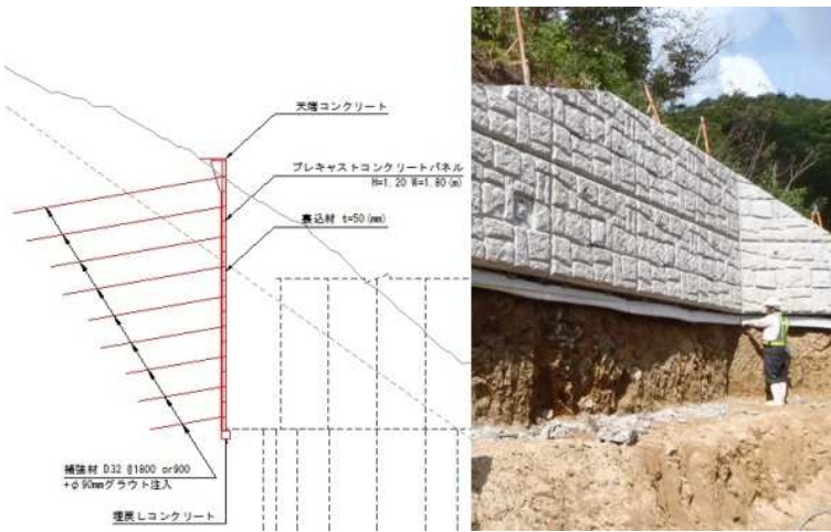
写真-1 断面図と垂直施工の様子
