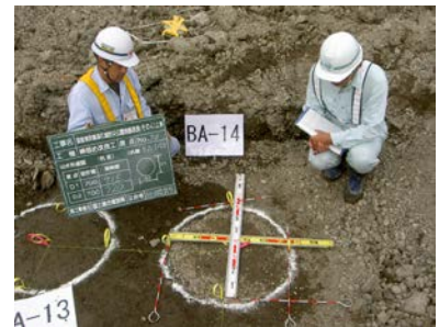
出来型杭径確認
