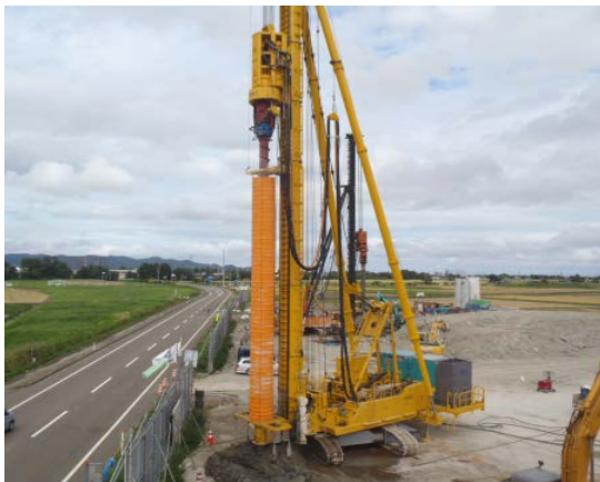
施工状況(KS-S・MIX)
