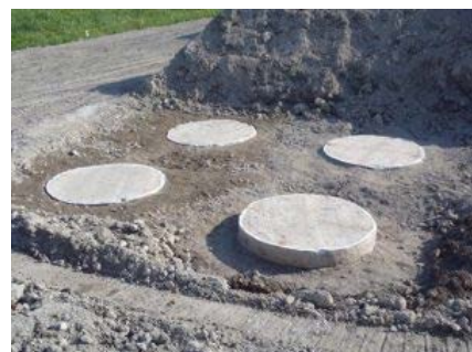
出来型杭径確認
