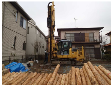
写真-1 狭隘地における小型重機による施工状況
