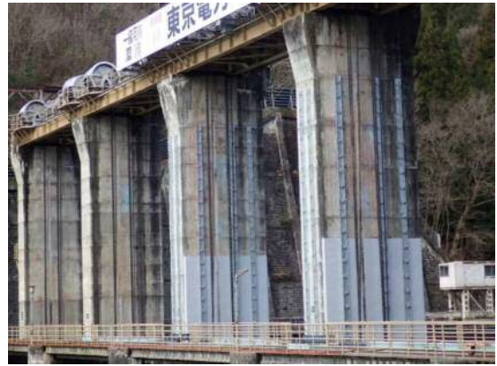
平発電所ダム(長野県)
