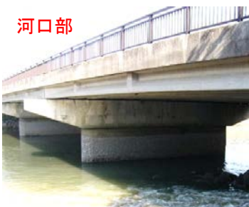
塩害対策（床版下面・地覆部に塗布）
