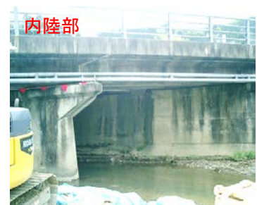
中性化対策（床版下面・橋台に塗布）
