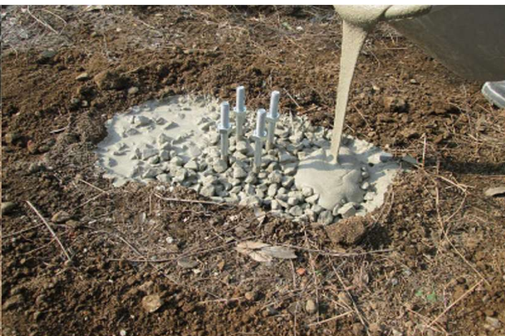
適用例(農業ハウス支柱基礎工事):充填状況
