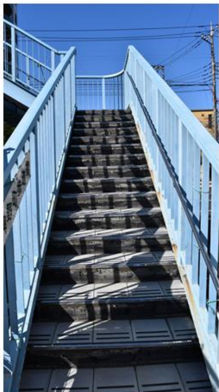
図2 事例: 歩道橋の補修
