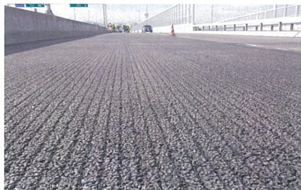
仕上がり路面の例 (福岡都市高速)
