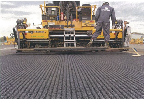
シニックスクリードによる敷均し状況
