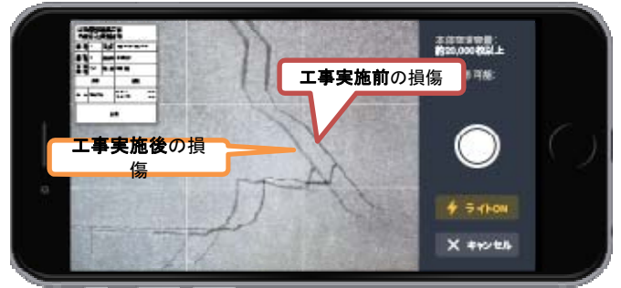
事前の写真がオーバーレイ表示され亀裂が比較でき
