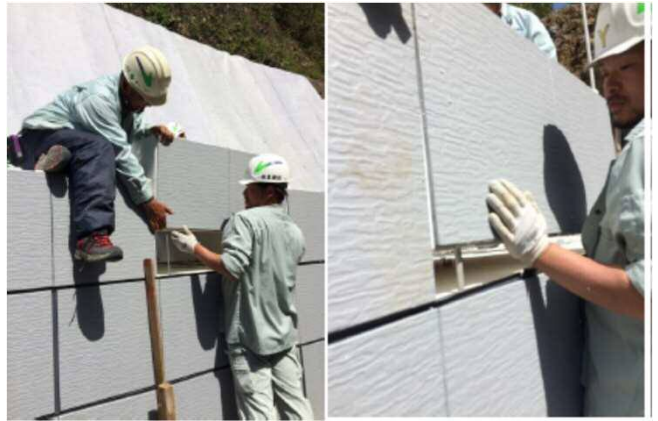
【J-ウォールブロック工法の積層イメージと施工写真】
