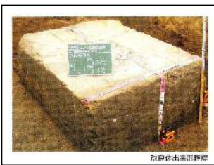
写真-2 改良体出来形
