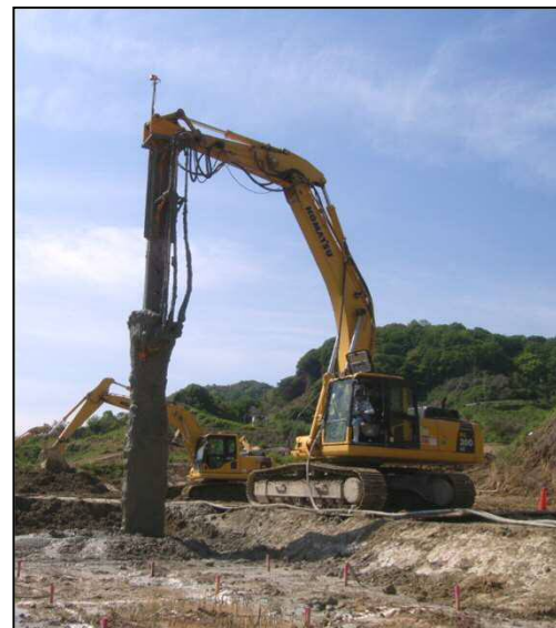
写真-4 10m仕様改良機 施工状況
