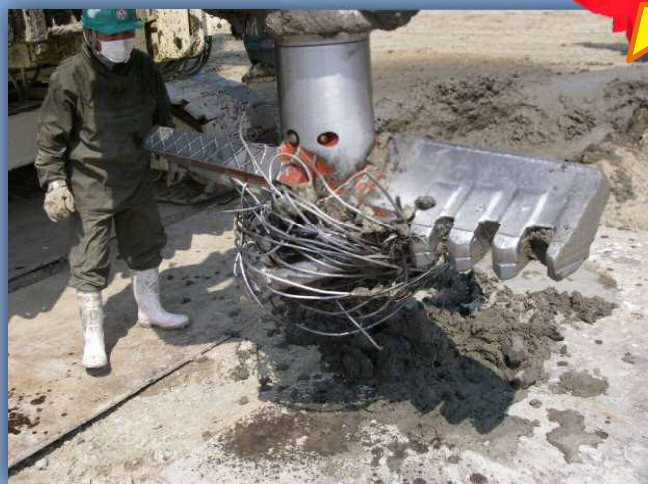
杭破碎同時施工
