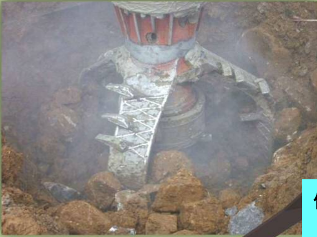
硬質地盤施工
