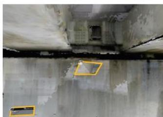
▲ 橋台および縦桁・床版下面の変状データ・写真
