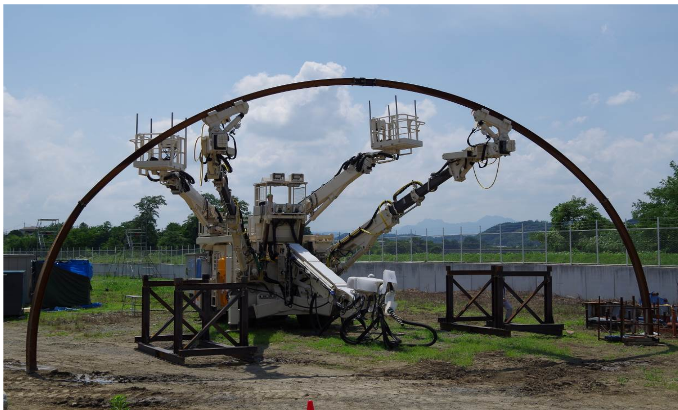
鋼製支保工建込みロボット全景
