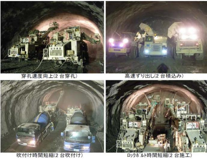
穿孔速度向上(2台穿孔)      高速ずり出し(2台積み込み)
