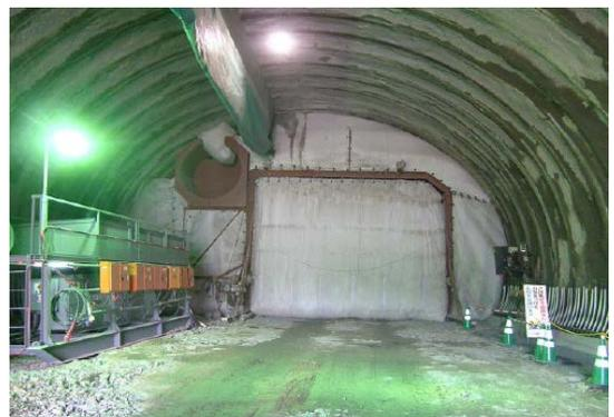
図-7 マルチバルーン(発破防護時)
