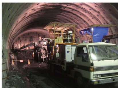
現場での稼働状況
