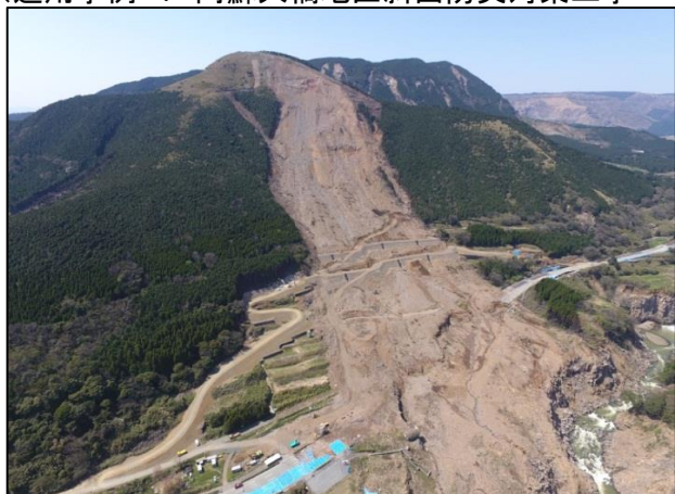
無人化施工エリア全景
