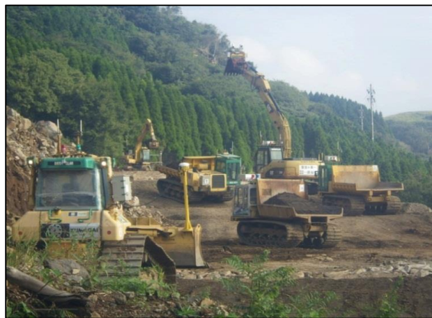
土留盛土工無人化施工状況
