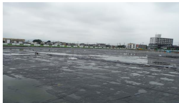
写真-2.2 真空運転状況
