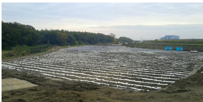
写真-2.1 施工状況
