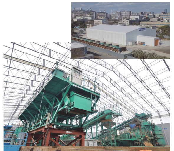
写真1 九大旧箱崎キャンパスの洗浄プラント外観
