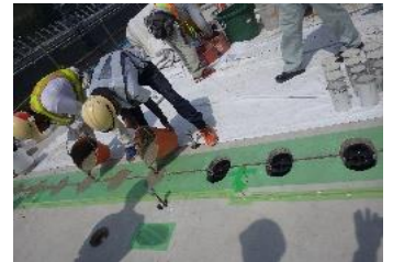
④目地材注入
