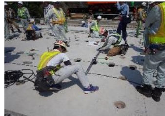
③H型金物挿入・ボルト締付
