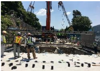
①床版荷下ろし
