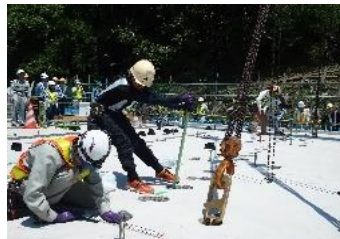
②床版設置
