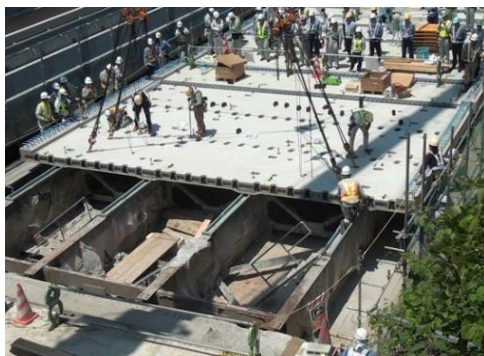
写真-2 試験施工状況
