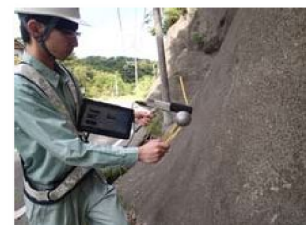
吹付けのり面での調査状況
