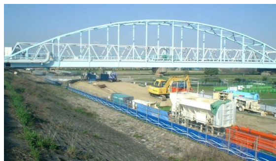
写真－4 橋梁下における施工
