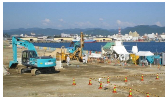
写真－3 護岸背面部の施工
