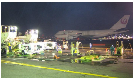
写真－2 空港誘導路における施工
