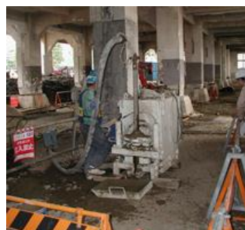
写真－5 空頭制限下の施工
