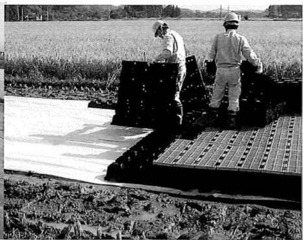
写真① プラロード敷設状況 (軽量で敷設に重機を必要としない)
