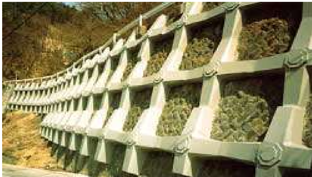
PCフレームアンカー工法
