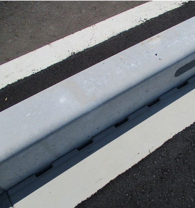
写真-1 施工現場写真
