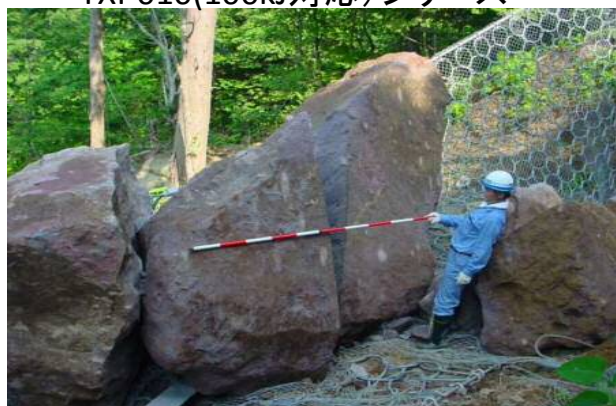
巨大落石捕捉実績
