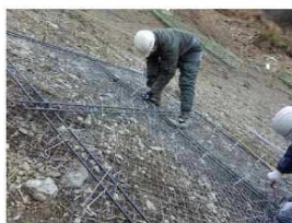
3. 鉄筋・組立枠設置
