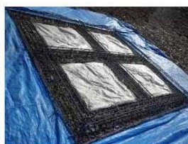
5. 枠内シート設置
