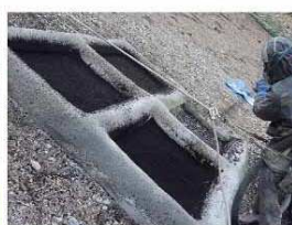
7. 植生基材吹付
