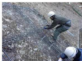
4. アンカー打設
