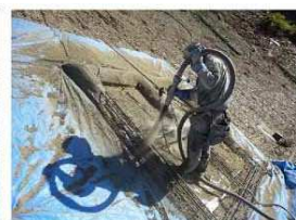
6. 枠内シート吹付
