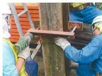
H形鋼支柱への取り付け状況
