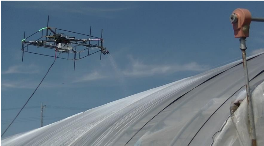
図1:ビニールハウスの屋根に遮熱材を吹き付ける様子
