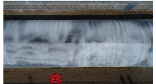
図1:ビニールハウスの屋根に遮熱材を吹き付ける様子
