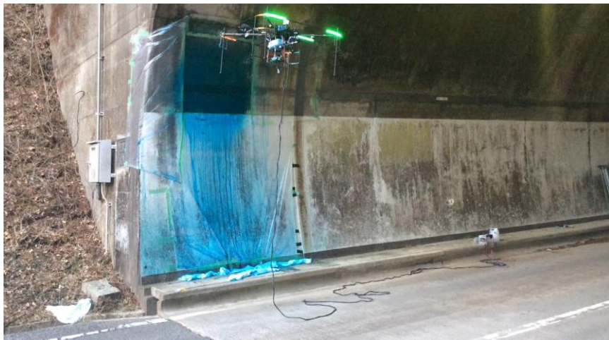
図2:トンネル内でコンクリート補修材を吹き付ける様子
