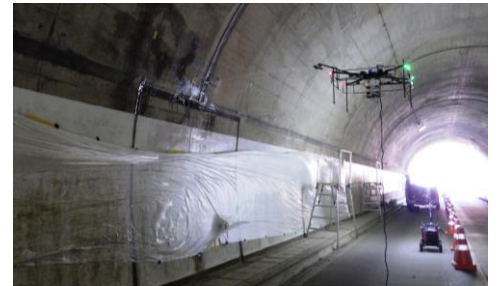
図2:トンネル内でコンクリート補修材を吹き付ける様子
