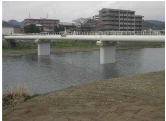
多々良水管橋(福岡県)
