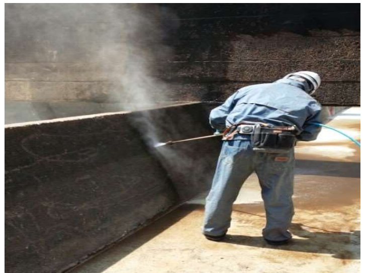
5. ターボガン使用中（施工現場の一部）
