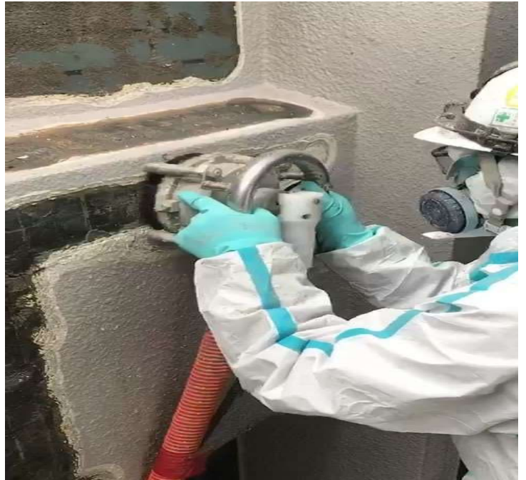
2. ウォールクリーナー使用中（施工現場の一部）
