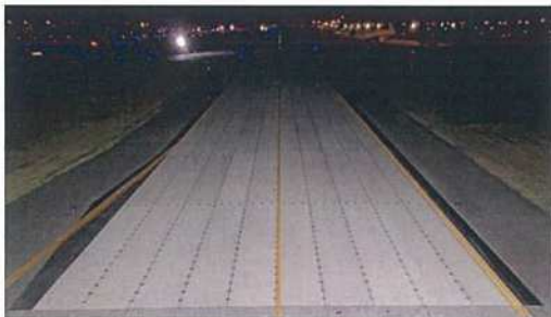
福岡空港誘導路完成写真
