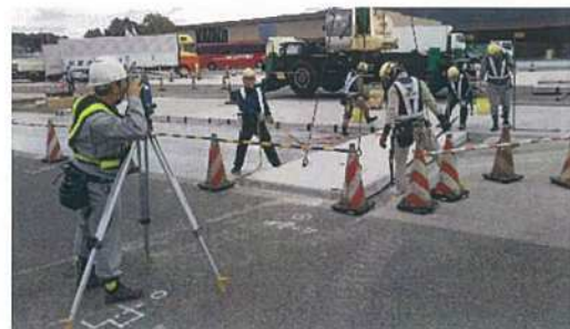
九州自動車道古賀SA施工状況
