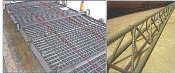
鉄筋籠(左)とラチストラス鉄筋(右)
