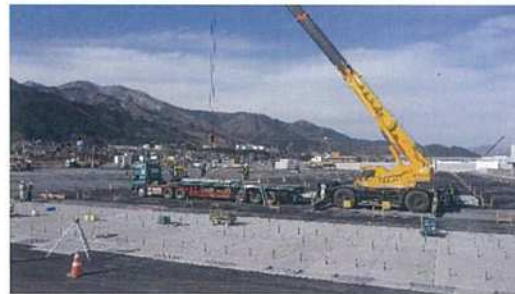
大船渡港施工状況
